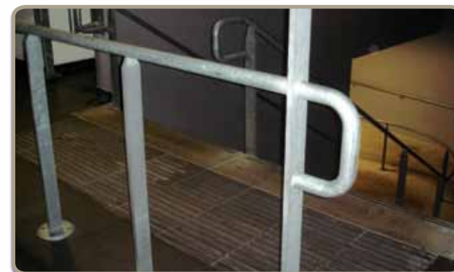
Илл. 16 – Тактильное (предупреждающее) покрытие пола с ограждением на верхней площадке лестницы
