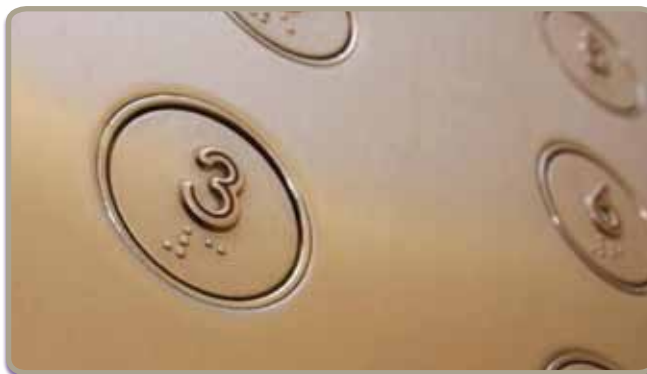
Илл. 11 – Панель управления лифтом с тактильными цифрами и шрифтом Брайля
